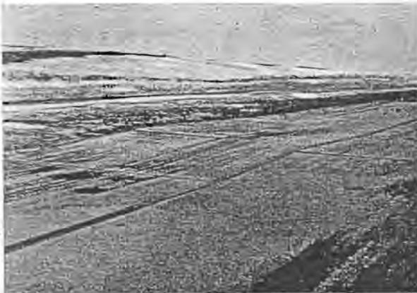
Abb. 1: Aufsattlung und Rißbildungen infolge Frostauftriebs im vorderen Drittel des Deckenfeldes; die Fugen sind verdübelt und ohne Stufen
