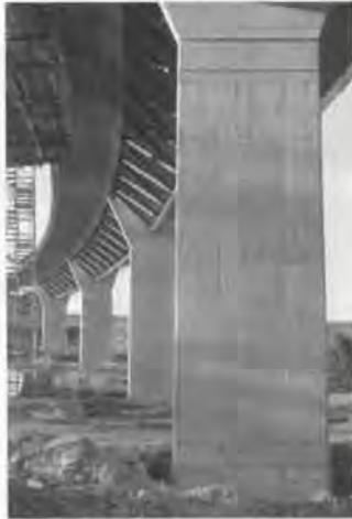
*Rohrfachwerk-Verbundbrücke mit Stahlgußknoten und Betongelenken im Zuge der neuen Umgehungsstraße Korntal-Münchingen bei Stuttgart
