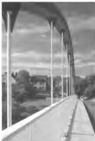
Bogen mit Hänger der neuen Stabbogen-Verbundbrücke in Mühlacker/Baden-Württemberg über die Gleisanlagen der Bahnlinie Stuttgart – Karlsruhe im Zuge einer innerstädtischen Entlastungsstraße. (s. Beitrag S. 416–421) (Foto: Dietmar Strauß, Bildermacher)
