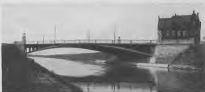
Abb. 1. Straßenbrücke über den Mittellandkanal bei Hannover. Stützweite 52,8 m, erbaut 1912. Louis Eilers, Hannover-Herrenhausen.
