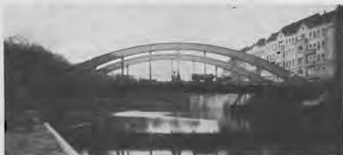
Abb. 2. Schloßbrücke über die Spree in Berlin-Charlottenburg. Breite 27 m, erbaut 1927. Krupp-Druckmüller, Tempelhof.
