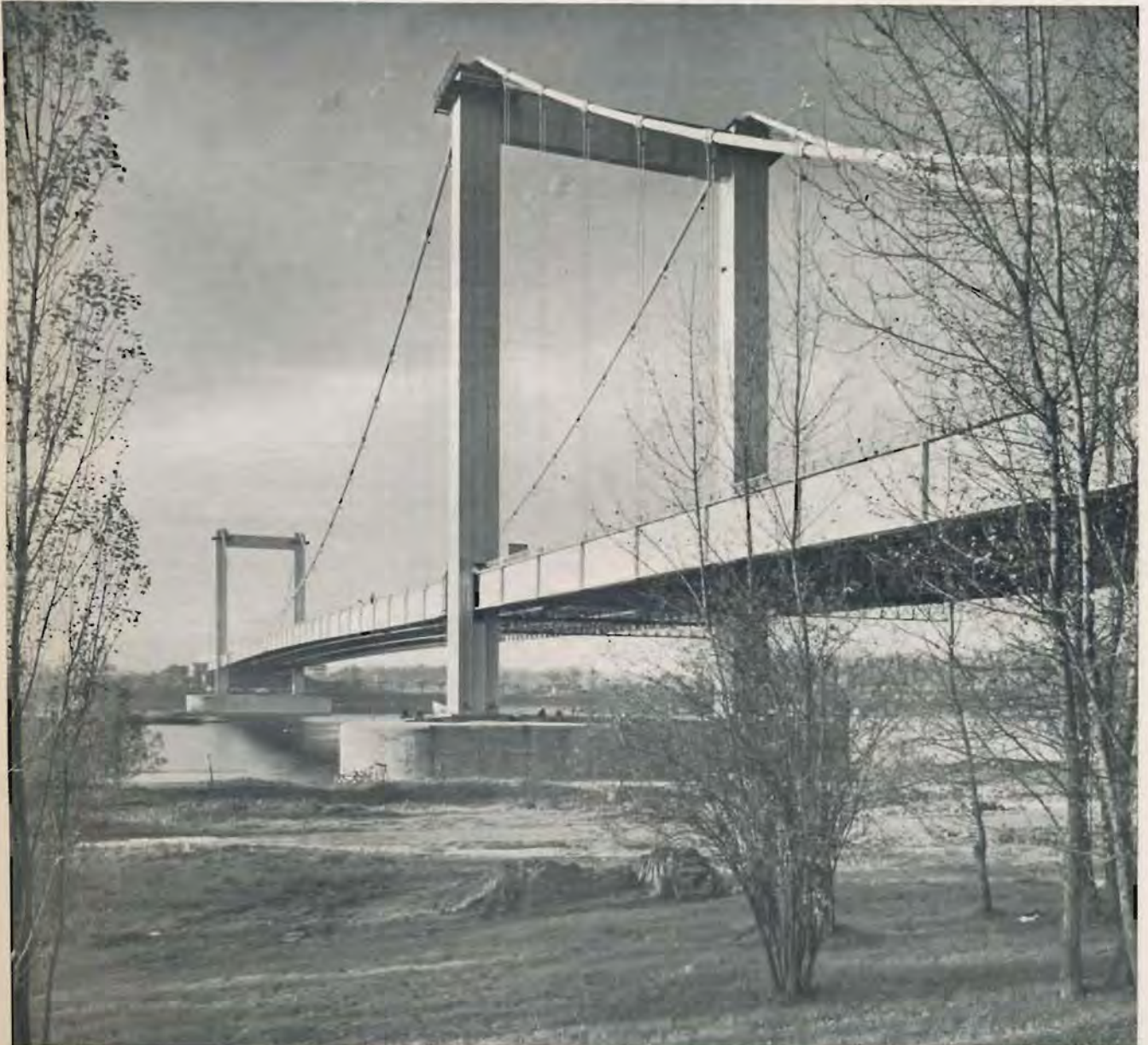
Die Autobahnbrücke über den Rhein in Rodenkirchen bei Köln
