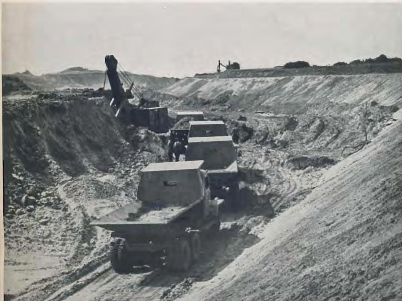
Gewinnung von sandigem und lehmigem Schüttmaterial aus dem Erdlos II Aachen mit M.-&H.-D-Bagger  $1,45 \text{ m}^3$  Löffelinhalt und Nordap-Erdtransportwagen ( $5,5 \text{ m}^3$ )
