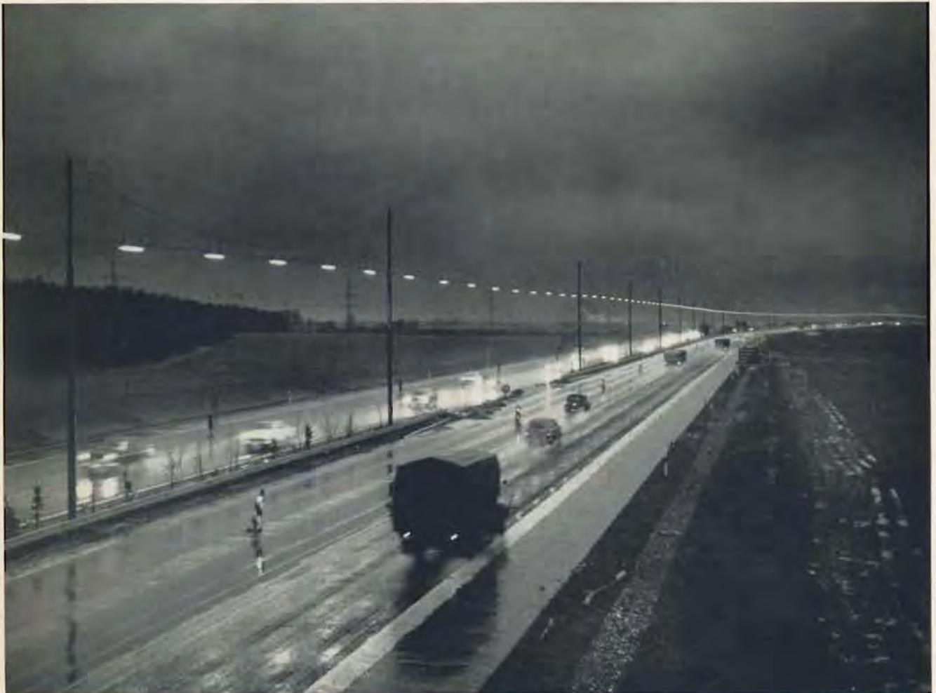
Bild 1: Bundesautobahn zwischen Köln und Leverkusen im Beleuchtungsabschnitt mit Längskette während der Verbreiterung auf 6 Fahrspuren
