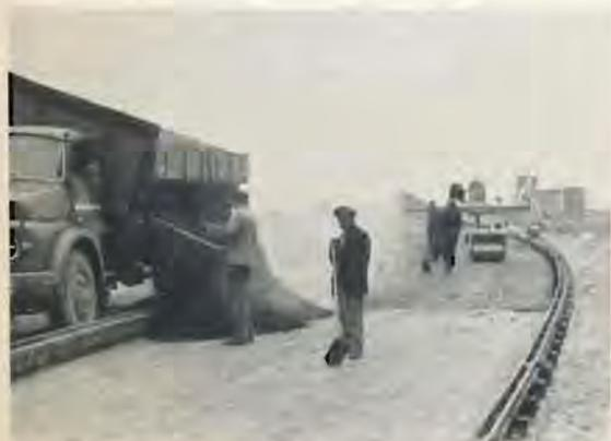
Abb. 5. Einlagiger Einbau von heißem Asphaltmischgut als Tragschicht für eine Zementbetondecke nur mit Schwertverteiler auf einer Panzerstraße des Truppenübungsplatzes Bergen-Belsen
