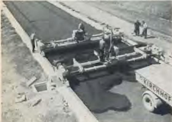
Abb. 4. Tragschichteinbau mit heißem Asphaltmischgut für eine Zementbetondecke mittels Schwertverteiler und nachfolgender Abziehbohle in Baden-Württemberg
