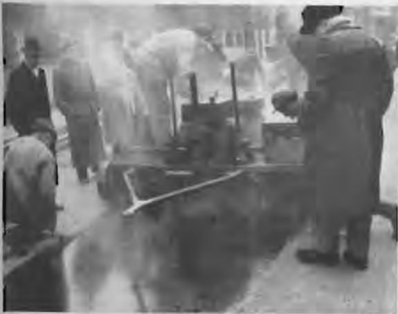
Abb. 1. Verlegen des Mittelstreifens zwischen zwei erkalteten Seitenbahnen
