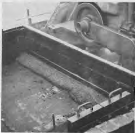
Abb. 3. Die Hartgußasphalt-Masse vor der Fertiger-Bohle
