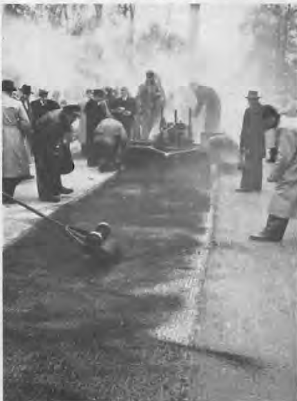
Abb. 2. Aufrauhung des noch plastischen Mittelstreifens. Die Nähte sind fast ausschließlich Maschinenarbeit
