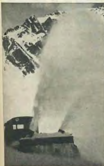
Fig. 8 Erste Durchfahrt der Fräse Premier passage de la fraiseuse
