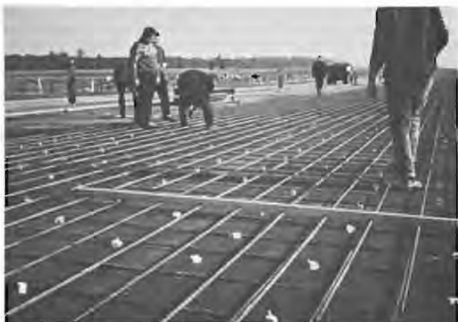
Instandsetzung der Autobahn Bremen—Hamburg bei Sittensen durch Hocheinbau einer durchlaufend bewehrten Betonplatte
