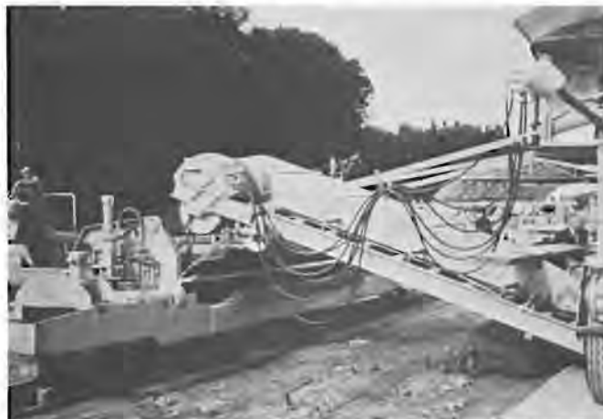
Moderner Maschineneinsatz beim Bau der Blocklandlinie bei Bremerhaven: Seitenbeschickung des Verteilers mit einem luftbereiften „side-leader“ von der Gegenfahrbahn aus
