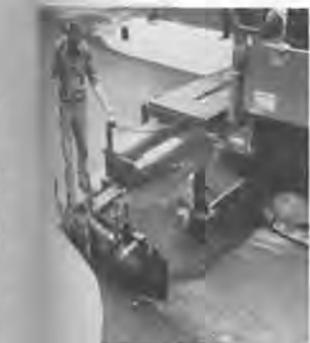
Super 1700 mit Ausziehbohle 475, Einbaubreite: bis 6 m (Bei stufenloser Verstellung: 2,25 m).
