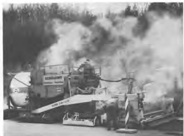
2: Reformer Super 1700 GARF mit Rückformwerkzeugen für Gußasphaltbeläge, Arbeitsbreite 3 m. Foto: Vögele
