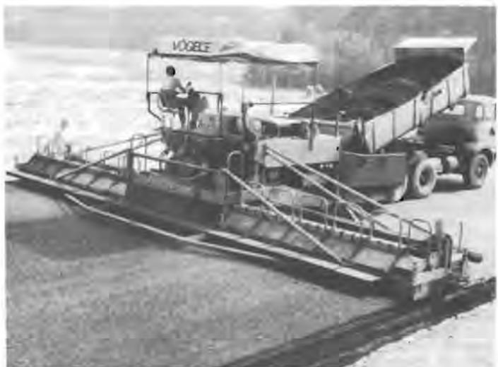
1: Fertiger Super 2000. Standardausführung mit schwimmender Einbaubohle — für Walzasphalt- und Magerbetonbeläge, Einbaubreite 12 m. Foto: Vögele
