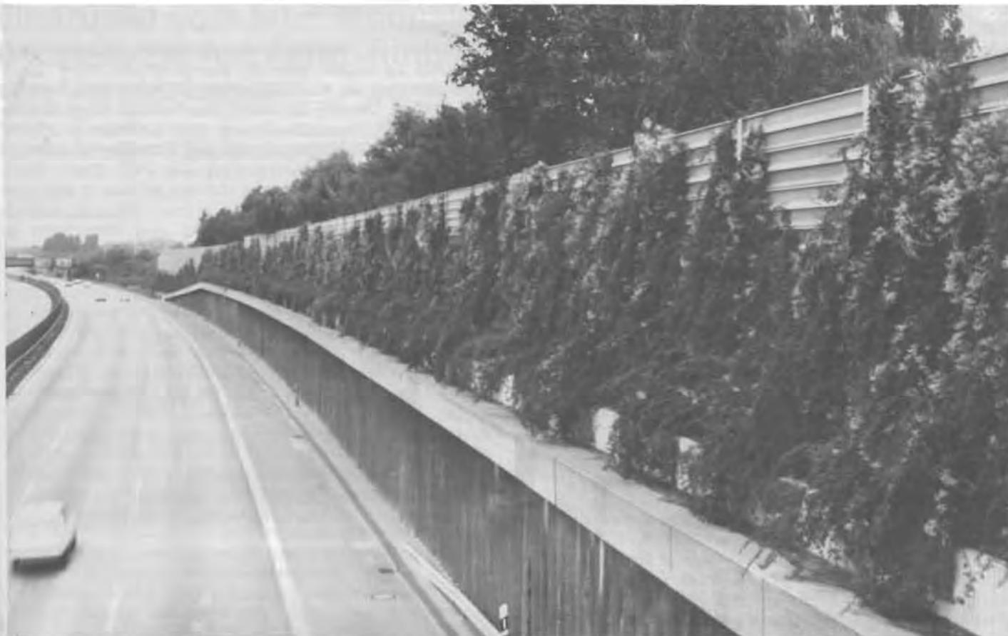
10: Absorbierende Schallschutzwand mit „vertikalem Grün“ (*Polygonum aubertii* Henry) an der A 7 bei Hamburg
