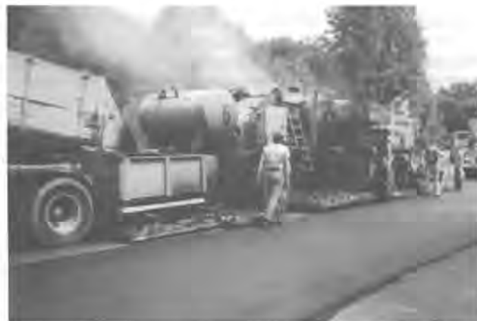
2: Zugabe des Zusatzmischgutes, Aufnehmen der Deckschicht und Herstellen und Einbau des neuen Mischgutes
