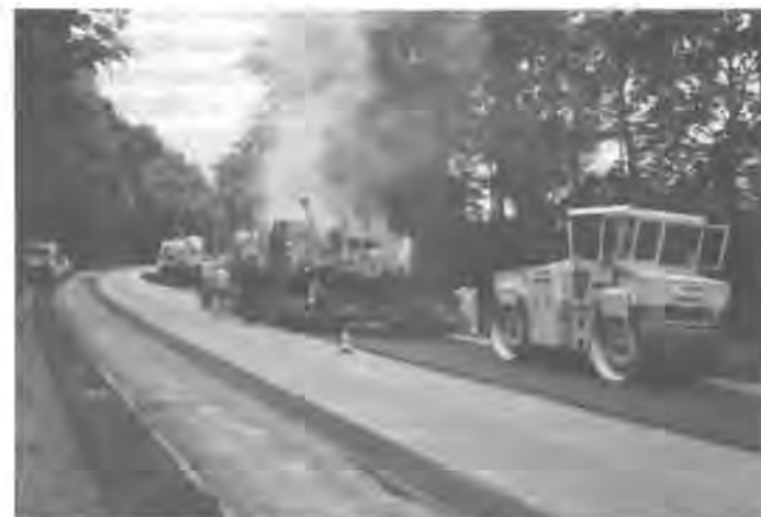
3: Gesamtansicht des Einbauzuges für das Remixverfahren
