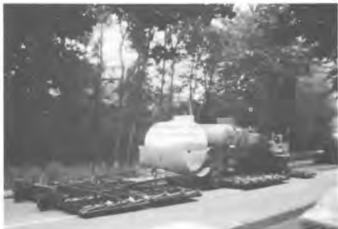
1: Aufheizen der zu erneuernden Deckschicht
