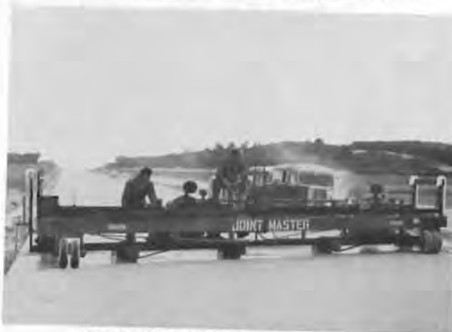
Abb. 9: Joint Master beim Fugenschneiden
