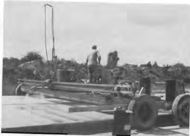
Abb. 8: Nachbehandlung mit aufgespritztem Film
