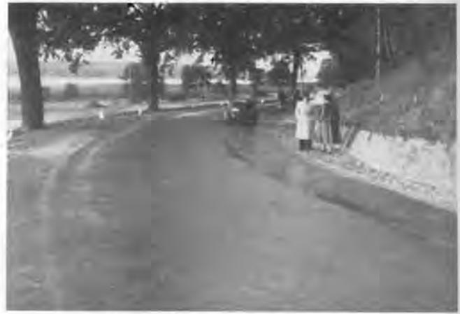
Abb. 61: Teerasphaltbeton auf der Havelchaussee
