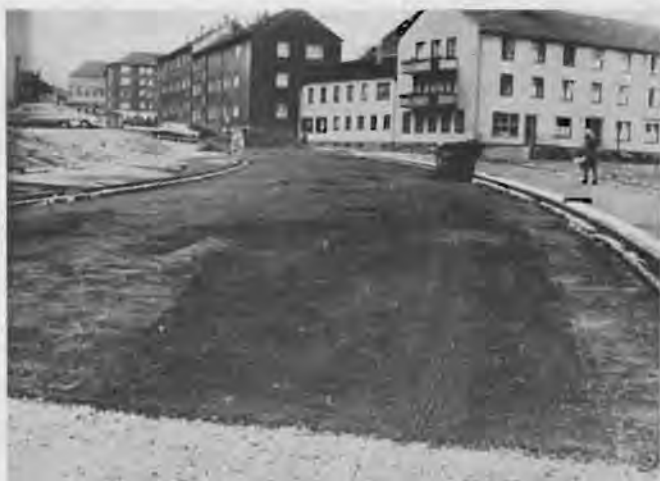
Abb. 2: Mit Rennschlacke verfülltes Rüttelschotter aus Hochofenschlacken in der Kerckhoffstraße
