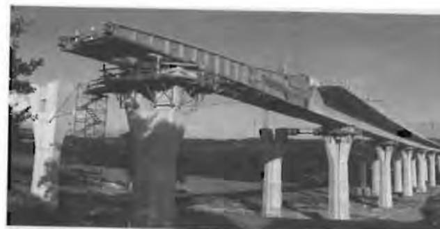
BW 5213/02 Talbrücke Nahe, A73 bei Schleusingen
