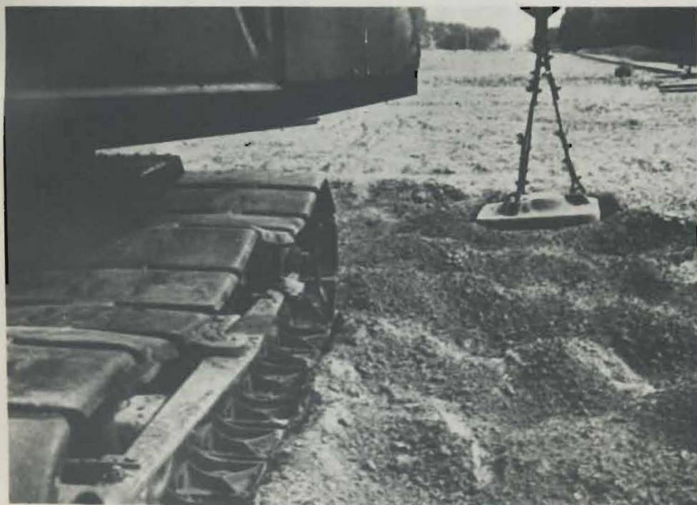
Bodenverdichtung mit Rammplatte
