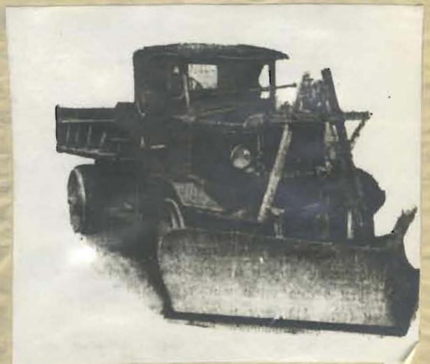
Abb. 41: Keilpflug an einem Lastkraftwagen.
