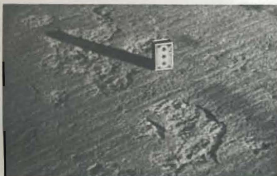
Fig. 1. Ytavflagnings på betongvägen vid Lingham.
