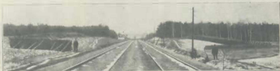
Abb. 23. Deckung eines niedrigen Einschnittes durch Hürden und Bockzaun.
