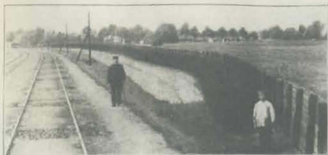
Abb. 21. Abgerückter Zaun für geringe Schneemengen.
