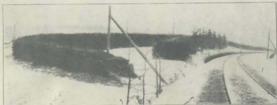
Abb. 24. Doppelzaun für 40 qm Ablagerungsfläche am Ende eines kleinen Einschnittes.
