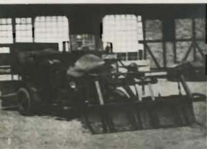
Krupp-Dreiradkehrmaschine mit Druckluft-Hebevorrichtung für Besenwalze und Schneepflug.
