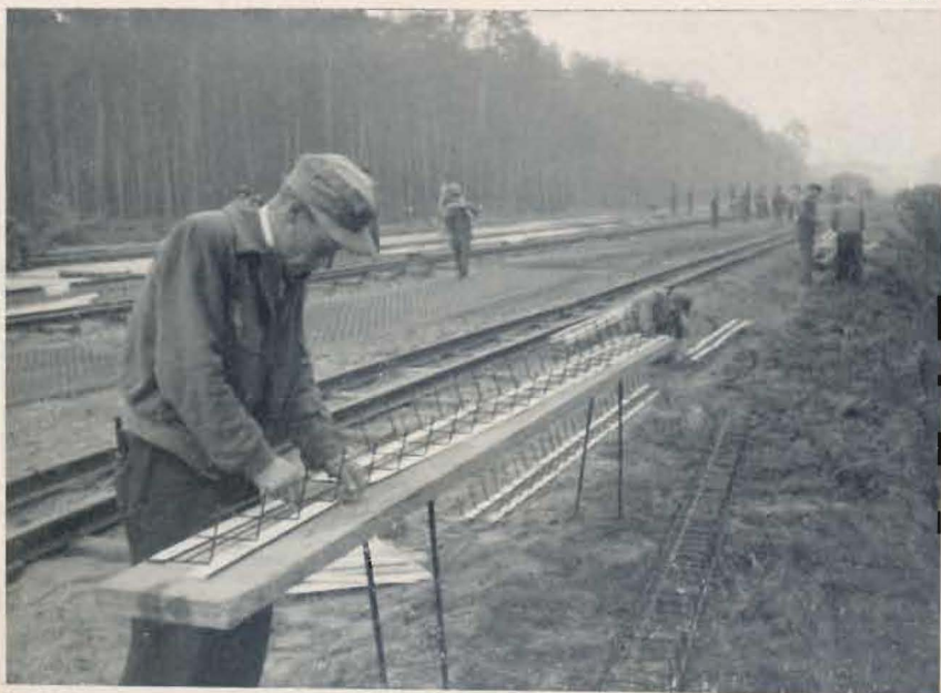
Abb. 1: Anbinden der Holzleisten
