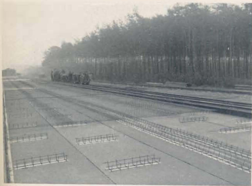
Abb. 2: Verlegte Bewehrung und Unterstützungskörbchen
