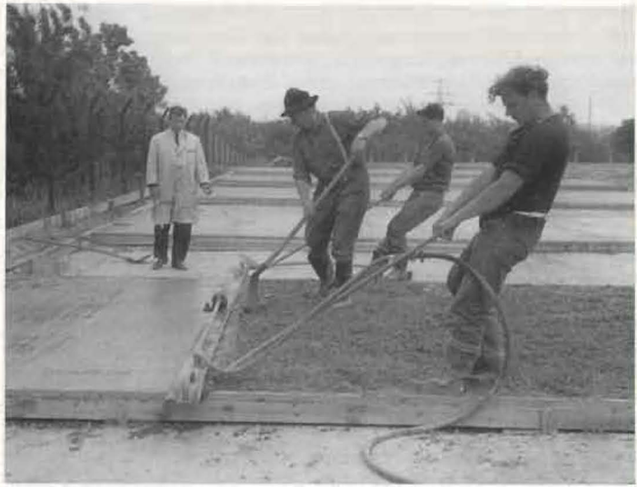
Bild 14 Preßluft-Rüttelbohle (Typ VG 350; Fa. Netter)
