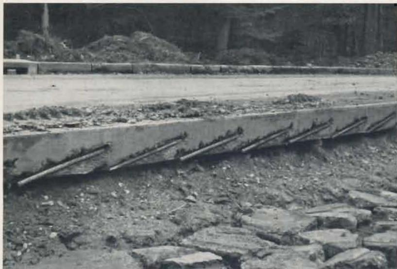
Bild 8: Freigelegte Längsdübel vor dem Aufbiegen
