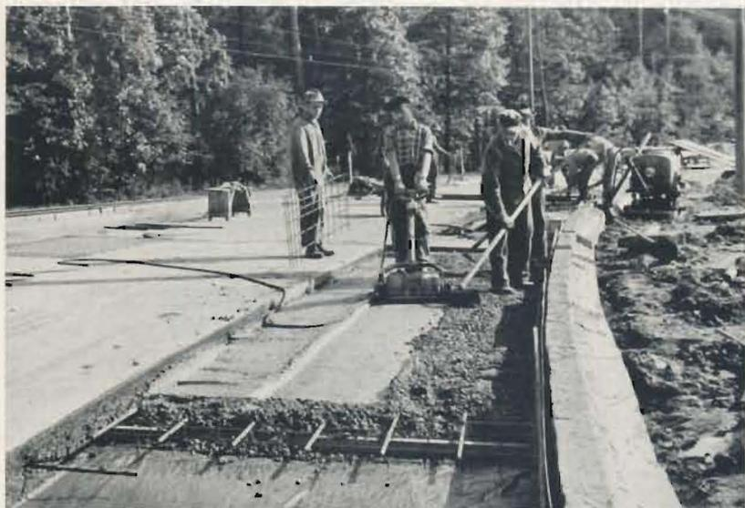
Bild 9: Seitenstreifen (Verdichten des Betons mit Rüttelplatte)
