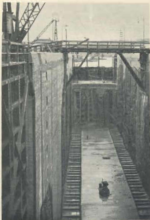
Kuva 3. Pällin sulku Saimaan kanavalla. Pohjajohdon teräsbetonikatots.
