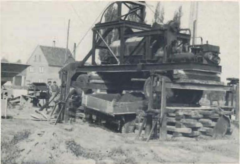
Abb. 325: Kipptrögmischer beim Herstellen von Schlammebeton
