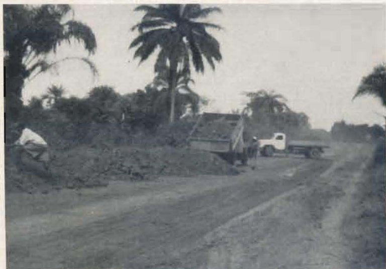
Abb. 213: Einbau des Lateritmaterials
