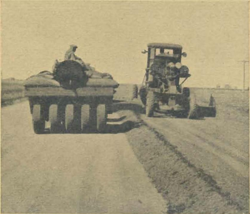
Abb. 21. Gummiradwalze zum Verdichten und selbstfahrender Straßenhobel zum Verteilen der Erdstraßenmischung (n. Pub. Rds. Bd. 24, NV. 2).
