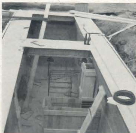
Abb. 1: Betonkammer unter der Fahrbahn für die Waage
