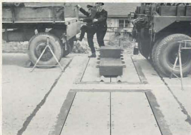
Abb. 2: Eichung der Waage mit ruhender Belastung
