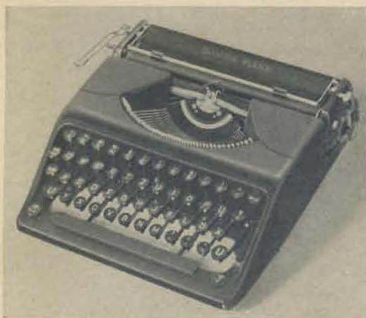
Bild 44. Schreibmaschine mit Preßstoffrahmen und Preßstoffsegment.
