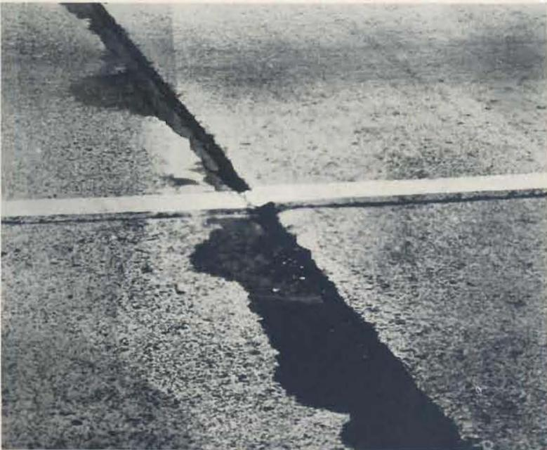
Abb. 2: Absprengungen an einer Fuge
