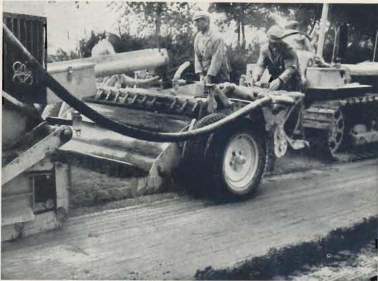
Abb. 1: Bodenverfestigung mit Zement mit dem Howard-Gerät
