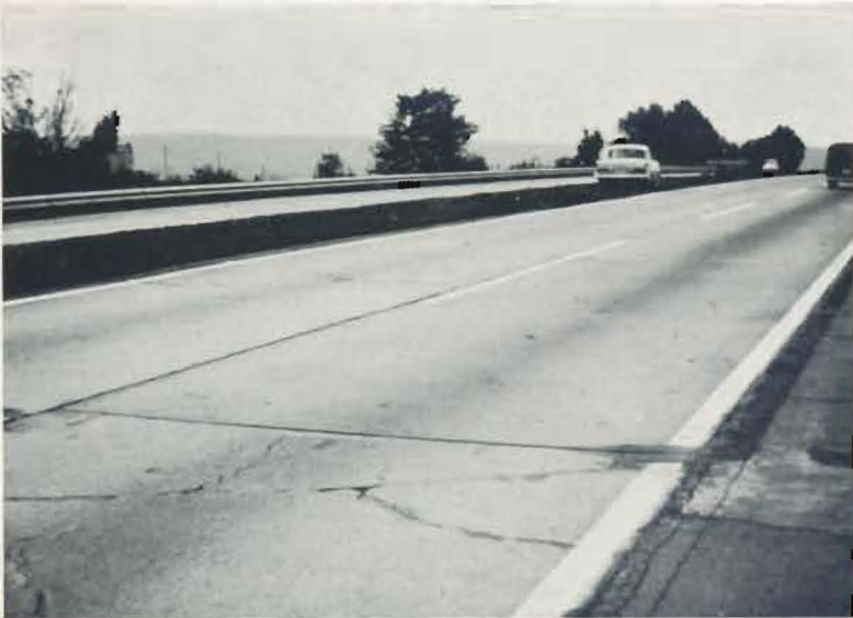
Abb. 74: BAB Stuttgart-Heilbronn (AS Stuttgart NW-Feuerbach AS Stuttgart-Zuffenhausen) km 577+300 die beiden ersten verlegten Fertigplatten
