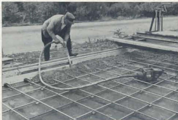
Bild 8: Verdichtung des Betons hinter den Verankerungen durch Rüttler.
