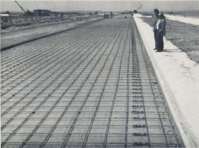
Abb. 9: Bewehrung mit geschlossenen Muffen
