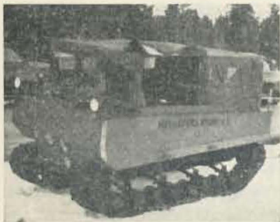
Kuva 104. — Ajaradan "polkemiseen" sekä lanan vetoon soveltuu erinomaisen hyvin lumitraktori. Paino n. 2 tn, moottorin teho 75 hv. ja suurin nopeus 51 km/t.
