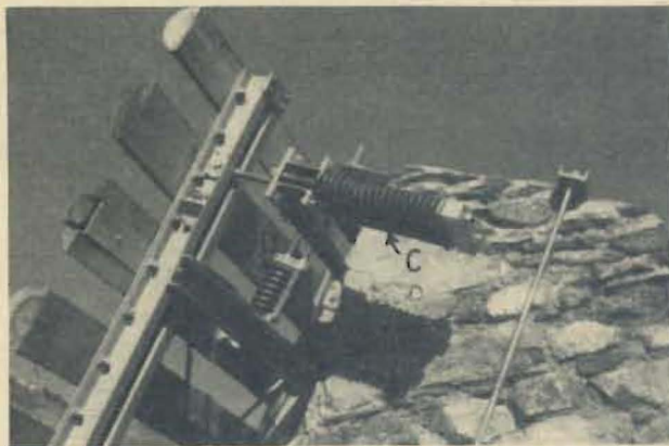
Abb. 23b. Detail des Schneedruckapparates Alp Grüm. C = geeichtes Federpaar einer der vier Auflagerstellen zur Uebertragung der Normalkomponente S_N des Schneedruckes auf den Mauerpfeiler. D = Feder zur Messung und Uebertragung der Querkraft S_Q (vgl. Abb. 24). (Photo H.)
