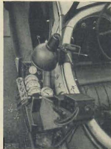
Bild 27. Auf dem Trittbrett angeordnete Instrumente.
