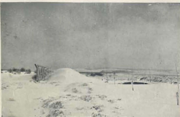
Fig. 7, 8, 9 et 10. — Effet d'un pare-neige sur la R. N. 102 A (altitude 1 300 m). Les congères aval ont 3 m de hauteur et la chaussée est parfaitement dégagée
