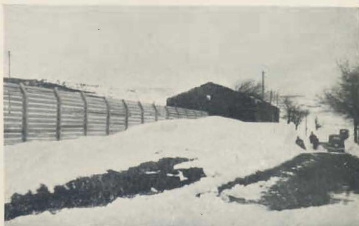
Fig. 7, 8, 9 et 10. — Effet d'un pare-neige sur la R. N. 102 A (altitude 1 300 m). Les congères aval ont 3 m de hauteur et la chaussée est parfaitement dégagée
