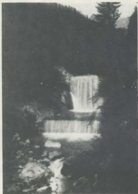
Abb. 11. „Marzingerbad, Nordtirol, Talsohle mit Fingersperre und Kolkecken, Bruchflächen bereits bestückt“.
