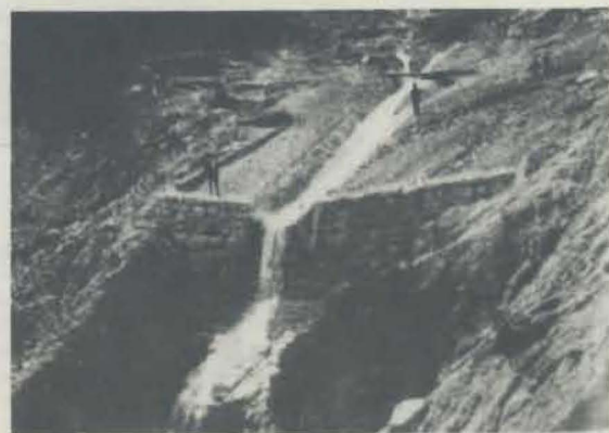
Abb. 14. „Loibach, Salzburg, Steinsperre und Schalenbau“.
