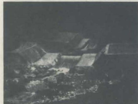
Abb. 12. „Weissenbach, Oberösterreich, Betonsperre mit Triftrinne“.
