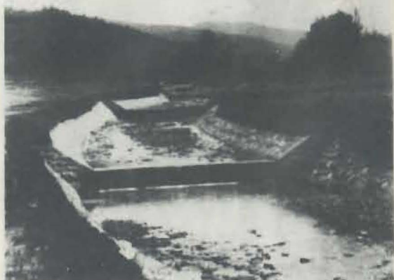
Abb. 13. „Jasenicaabach, Mähren, Regulierung mittels Leitwerken und Grundschwellen“.
