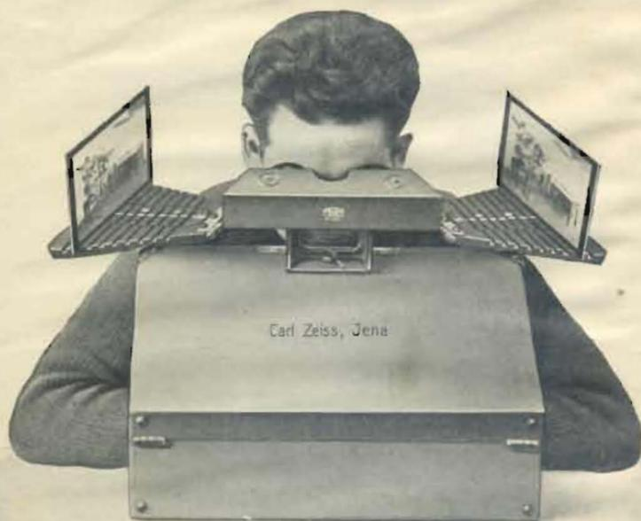
Abb. 51. Spiegelstereoskop nach Pulfrich
