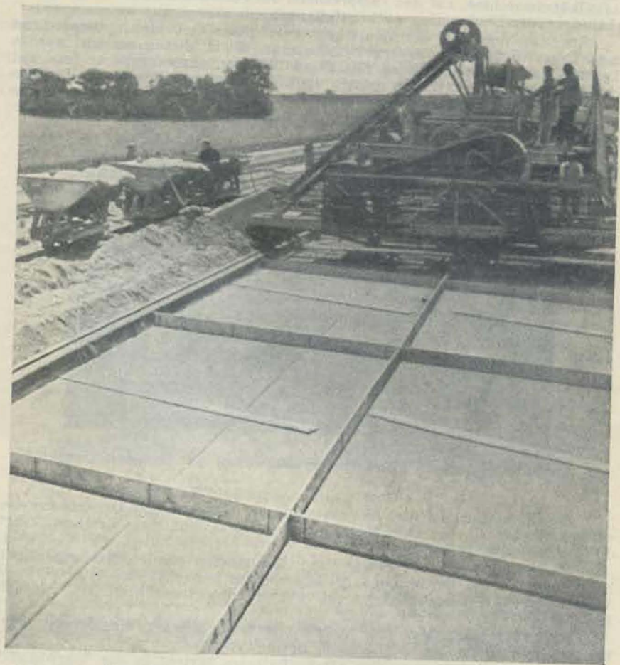
Abb. 138 a. Bau einer Betonstraße. Brückenmischer.
