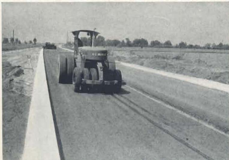
Abb. 8: Verdichten der unteren Lage mit Gummiradwalze
