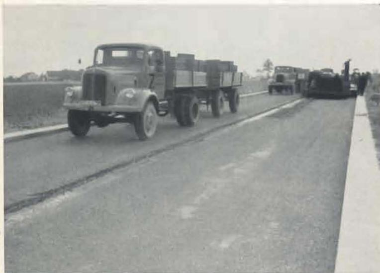
Abb. 9: Verkehr auf der frischen Teertragschicht
