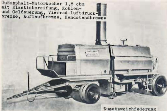
Abb. 1: Linnhoff-Gußasphalt-Motorkocher, 4—4,5 t Nutzinhalt
