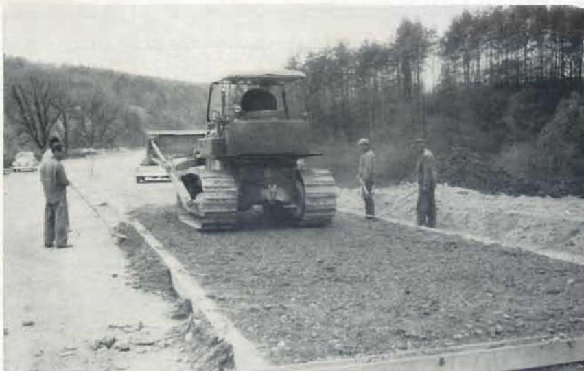
Abb. 4: Verteilen des von Lastkraftwagen auf Haufen geschüttelten Betons mit Planier-
