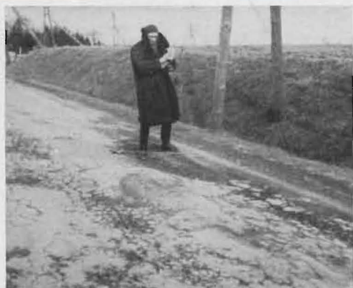
Abb. 3. „Irgendwelche Ausbesserungen der Frostaufbruchsstellen sind nicht erfolgt . . . Trotzdem sind die Froststellen durch Verkehr und Temperatur verschwunden.“
