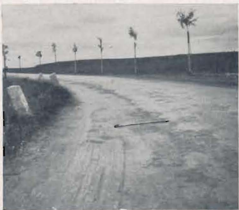
Abb. 4. „Die Rinne in der Straße rührt nicht vom Frostaufbruch her, sondern ist durch Verkehr in der Innenkurve ausgefahren . . . Kurvenausbau ist beabsichtigt. Soweit Frostaufbrüche vorhanden gewesen, sind sie ohne Ausbesserung durch Witterung und Verkehr ausgebügelt.“
