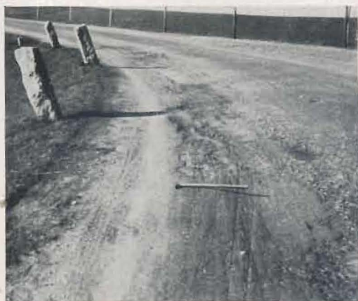
Abb. 4. „Die Rinne in der Straße rührt nicht vom Frostaufbruch her, sondern ist durch Verkehr in der Innenkurve ausgefahren . . . Kurvenausbau ist beabsichtigt. Soweit Frostaufbrüche vorhanden gewesen, sind sie ohne Ausbesserung durch Witterung und Verkehr ausgebügelt.“
