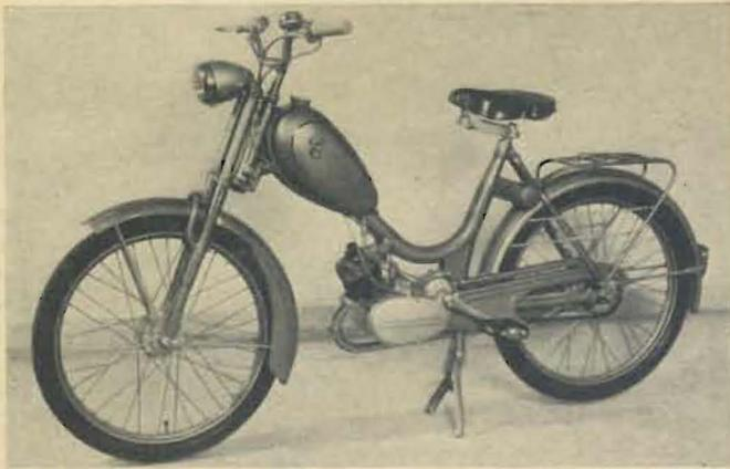
Bild 1. Typisches deutsches Moped aus dem Jahre 1954. Das des vorangegangenen Jahres unterschied sich von ihm nur durch den einfacheren Motor (ohne Wechselgetriebe). Vgl. auch ATZ 1953, Seite 282. \*
