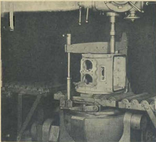
Bild 19. Schwenkvorrichtung zum Schwenken in zwei Ebenen zum Bohren schrägliegender Löcher auf einer Radialbohrmaschine
